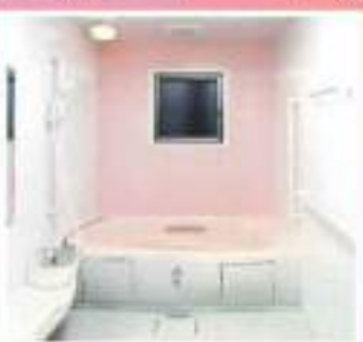
各階2つずつ設置の個浴 3階～5階には個浴を2つずつ設置しています。
